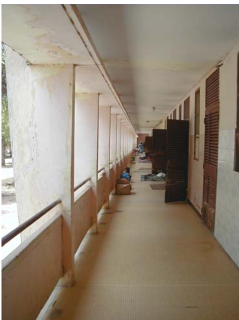
Figura 2.4- La struttura dell'Ospedale di Ziguinchor-
